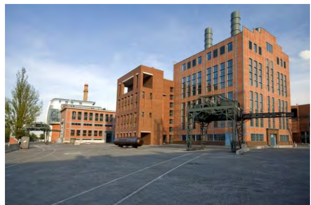
Рис. 8. Вид на західну частину колишньої електростанції ЕС-1 (м. Лодзь, Польща) [5]
