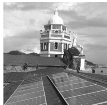
Рис. 8. Монтаж без регулювання кута нахилу
