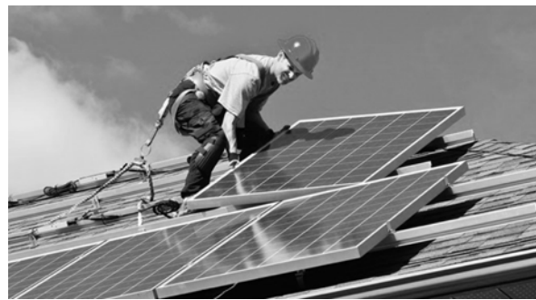
Рис. 8. Монтаж без регулювання кута нахилу
