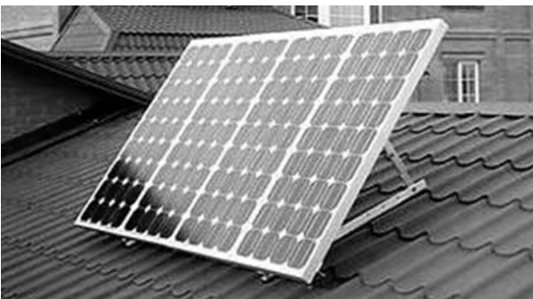
Рис. 7. Монтаж з регулюванням кута нахилу
