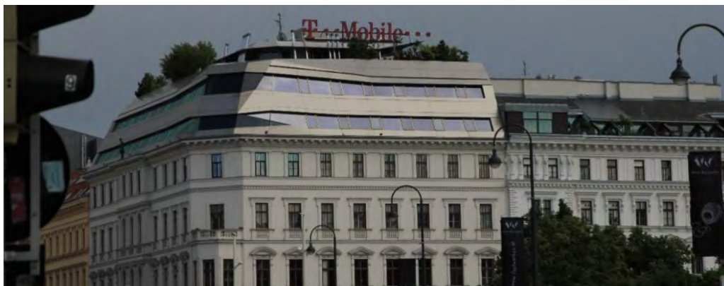
Рис. 3. Реконструкція усієї площі горищного поверху. Відень, Австрія [фото автора]
