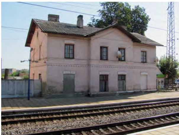
Рис. 3. Станційний будинок Батьово
