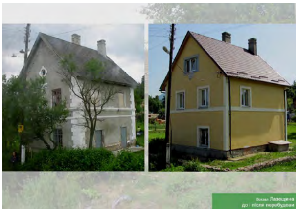
Рис. 1. Вокзал Лазещина до і після перебудови
