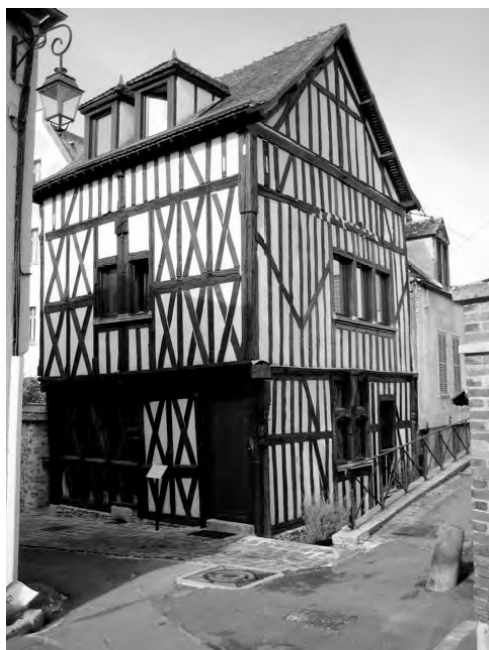
Fig.1 [10] Maison de la Turquie – Nogent-sur-Seine France. Renovation in 1986.
