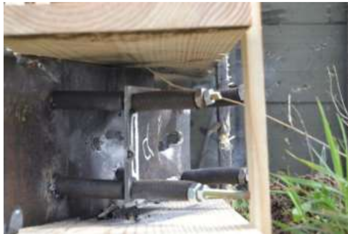
Фото 5. Захисна конструкція з підпружиненою сталюю пластинною.
