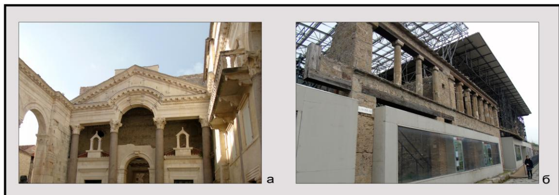
Рис. 3.7. Використання методу конструктивного зміцнення та накриття у консервації фрагментів архітектурних пам'яток
