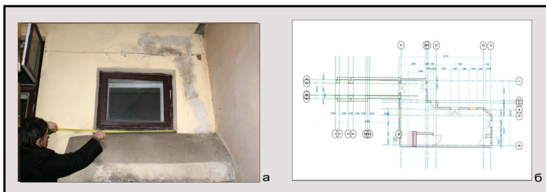
Рис. 5.4. Проведення передпроектних досліджень: обміри а - проведення архітектурних обмірів експозиційних просторів (фото автора); б - обмірні креслення (креслення автора)
