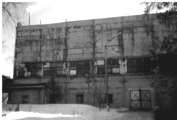
Іл. 1. Загальний вигляд цеху
