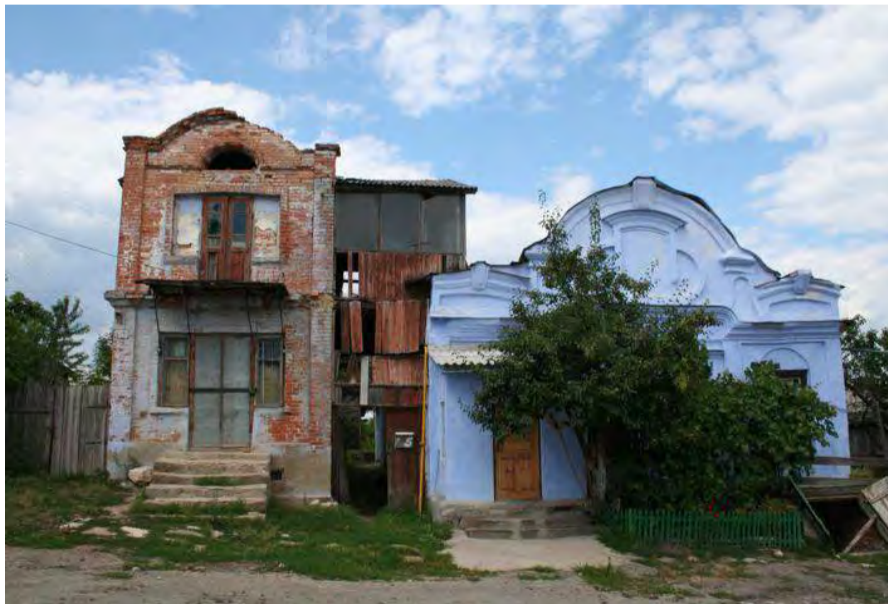
Нова Ушиця. Площа Ринок. Фото 2007 р. Приклад неналежного ставлення до забудови середмістя.
