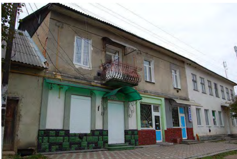
Вирішення проблеми упорядження фасадів. Площа Ринок в Журавно. Фото 2010 р.
