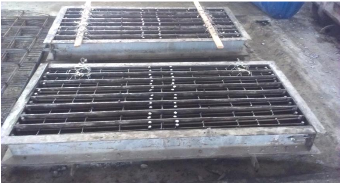
Рис. 2.4. Інвентарна форма з змонтованими каркасами балок
