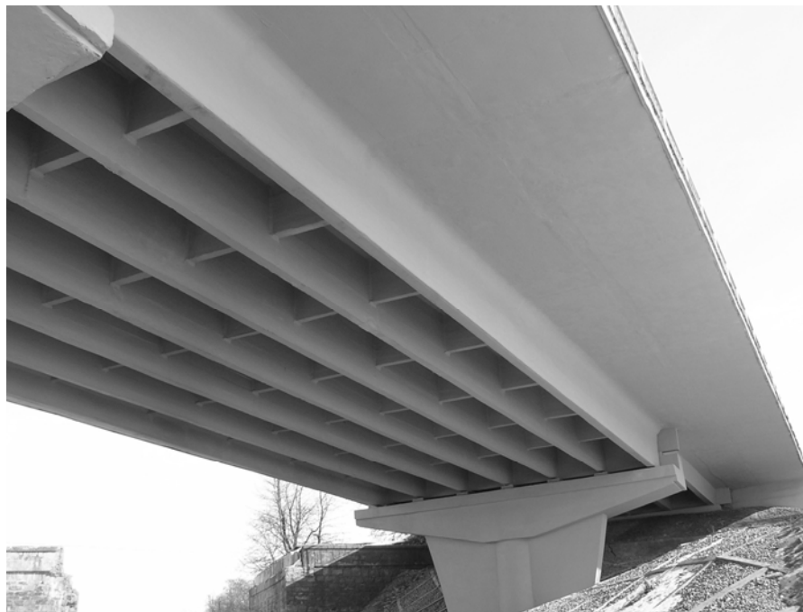
Рис. 15. Загальний вигляд шляхопроводу після реконструкції
