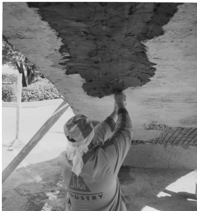
Рис. 8. Відновлення захисного шару бетону нижньої поверхні плити містка
