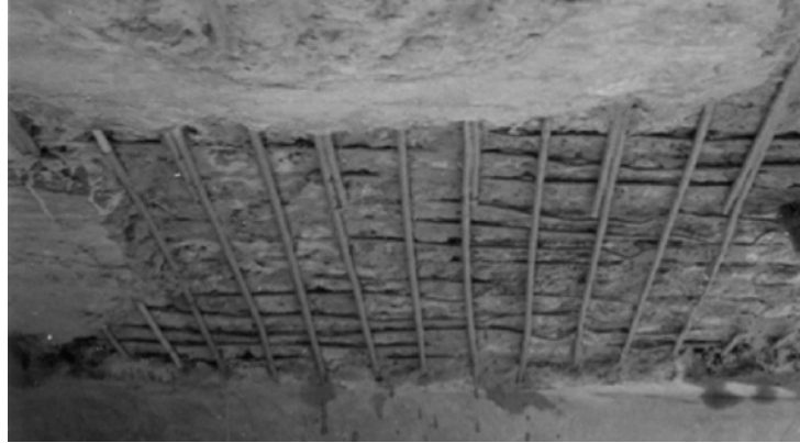
Рис. 7. Антикорозійний захист арматури
