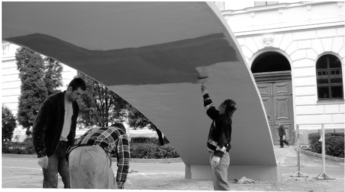
Рис. 9. Нанесення декоративного захисного покриття
