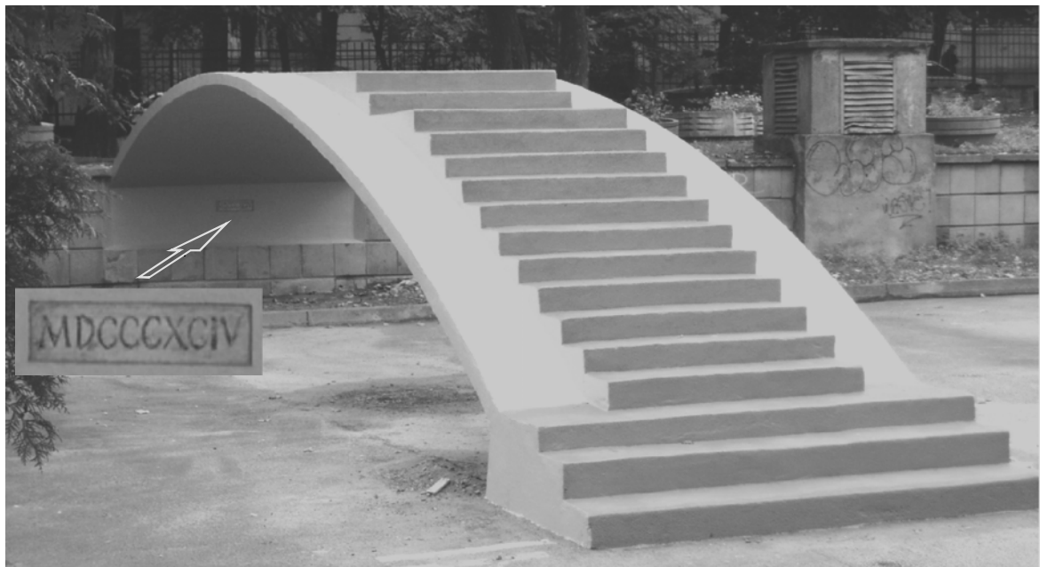
Рис. 10. Загальний вигляд містка після ремонту
