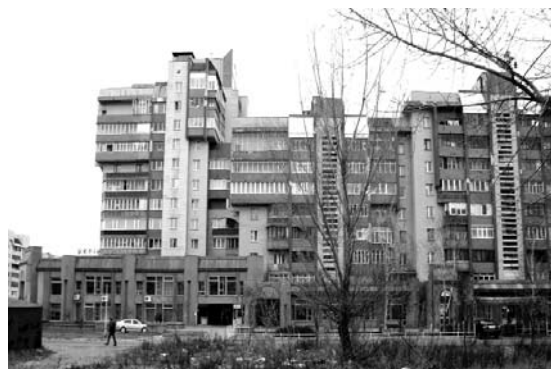
Рис. 3. Комплекс будинків по вул. Гагаріна
