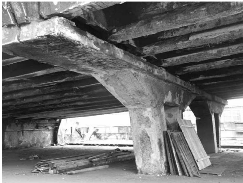
Рис. 1. Естакада біля станції метро “Шулявська” після пожежі
