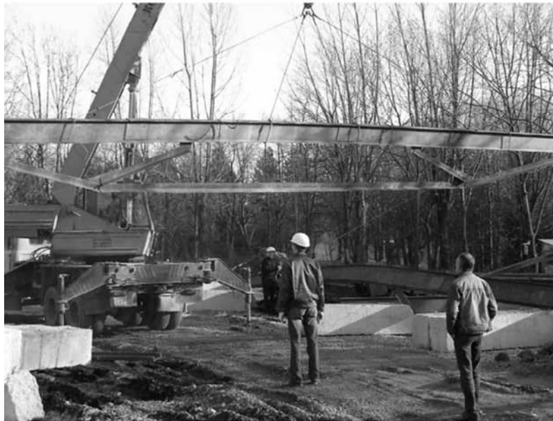
Рис. 2. Металева СНКК прольотом 18 м
