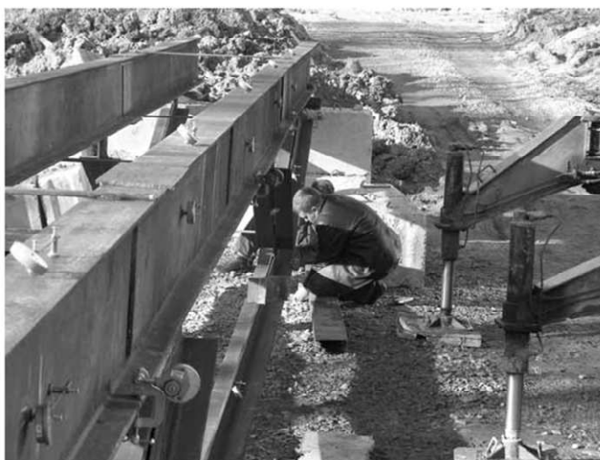
Рис. 6. Монтаж дослідного обладнання на СНКК спеціалістами НДЛ-19
