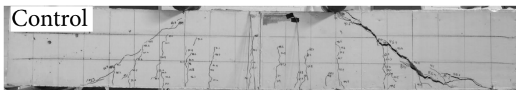
Рис. 5. Характер руйнування залізобетонної балки за поперечною силою [10]
