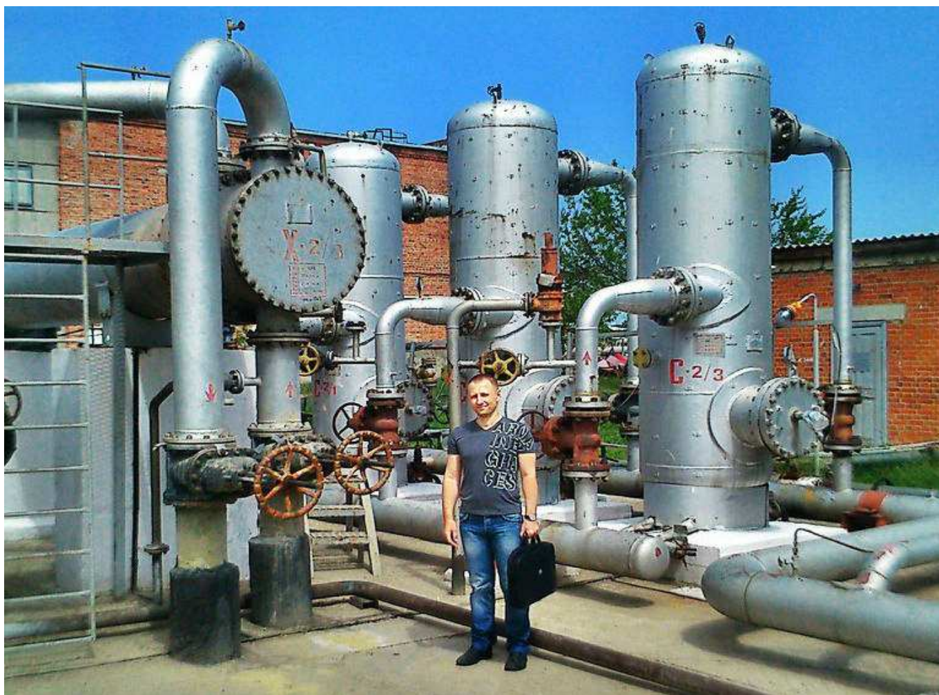
Рисунок 6.11 – Модернізовані лінійні газосепаратори з сепараційними блоками інерційно-фільтруючого типу (ПАТ «Укрнафта», Качанівський ГПЗ, 2013 р.)
