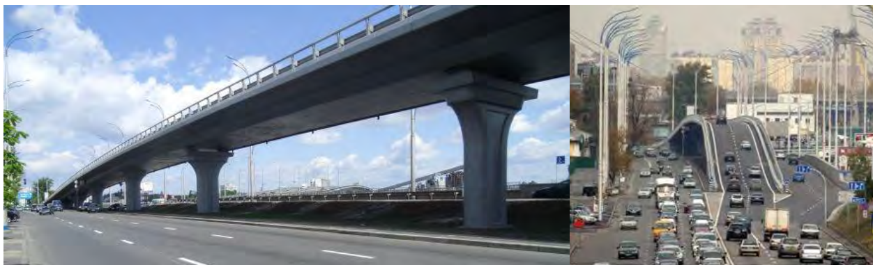
Рис. 7. Загальний вигляд естакади
