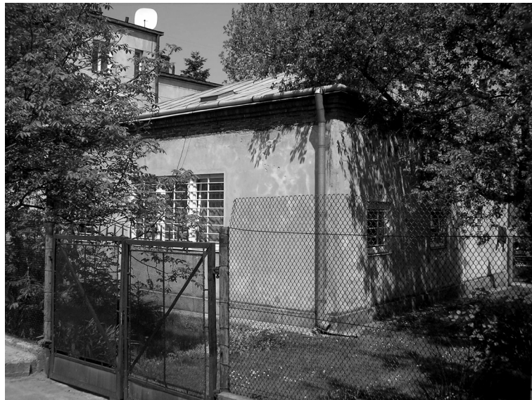
Рис. 4. Будинок "Під вербою" на вул. Ольжича, 3. Стан 2006 р. Фото автора
