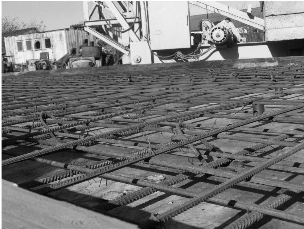
Рис.3.5. Вигляд анкерного пристрою та розміщення арматури
