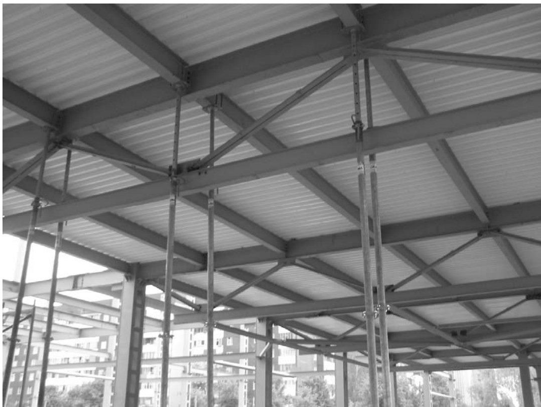
Рис.4.13. Вигляд знизу на конструкцію сталезалізобетонного перекриття, прольотом 12 м
