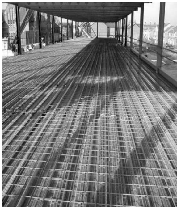
Рис.1.3. Армуння плити по СПН до бетонування
