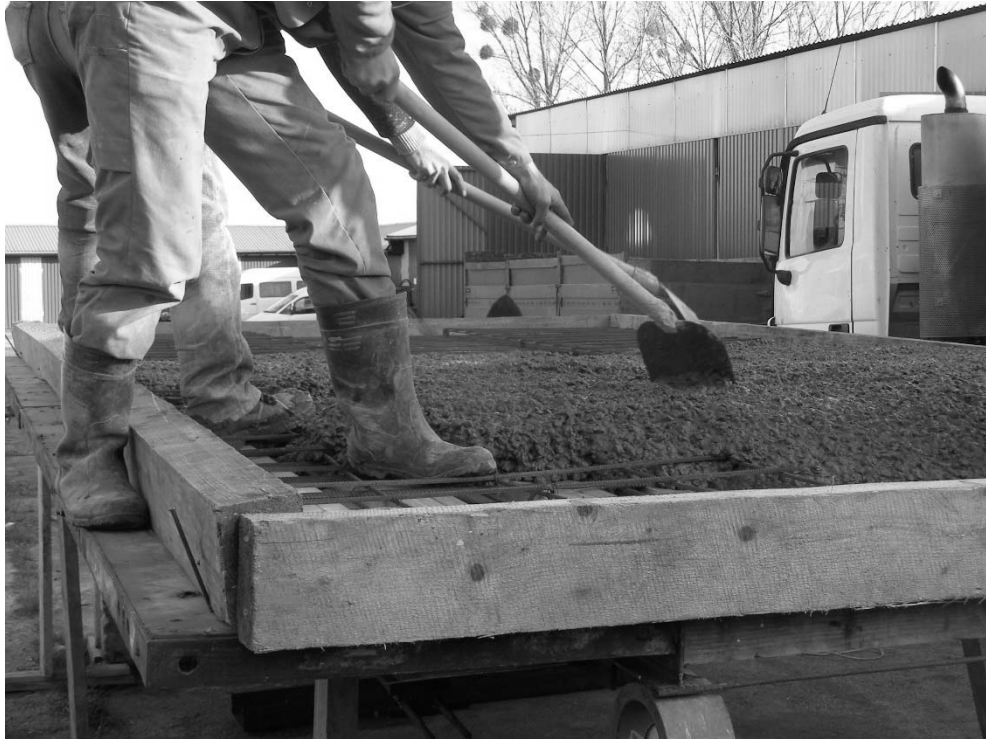
Рис.3.6. Бетонування плити дослідної конструкції КБС-3
