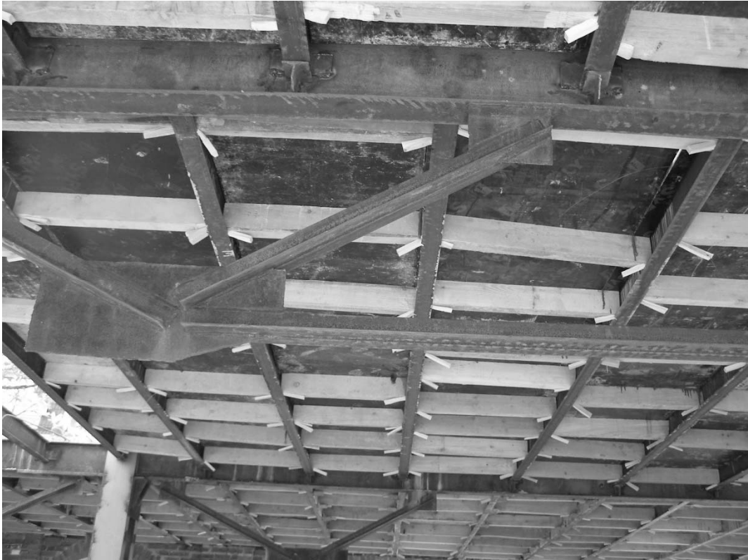
Рис.4.18. Сталезалізобетонне перекриття будівлі відпочинкового корпусу ТзОВ «Трускавецьінвест» на стадії бетонування (проліт 10м)
