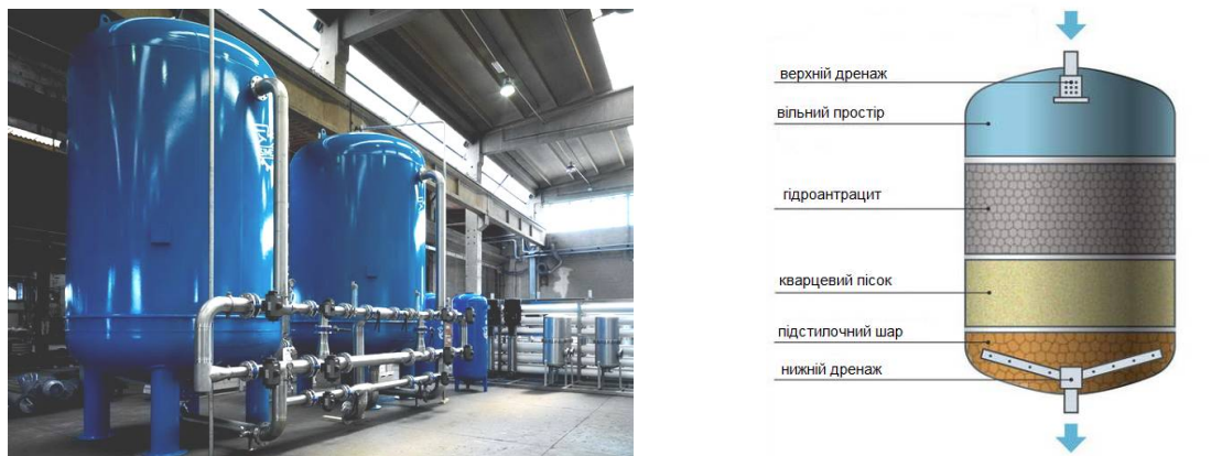
Рис. 1.6. Механічні фільтри [219] та їх конструкційна схема [210]
