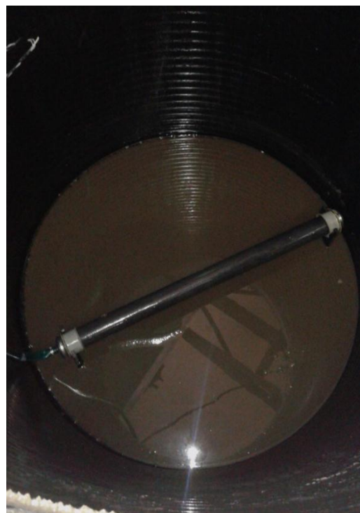
Рис.2.16 Фото трубчастого аератора
