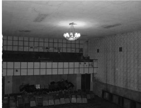
Рис. 8. Загальний вигляд стелі і задньої стіни з балконом глядацької зали
