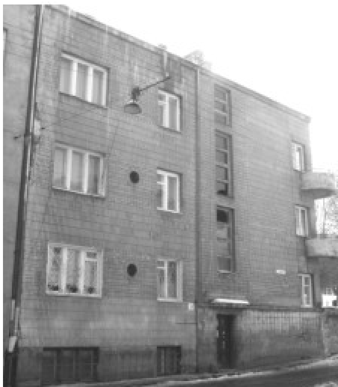
Рис. 2. Приклад розшивки фасаду “під цеглу” (вул. Зарицьких, 39)
