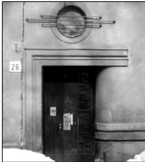
Рис. 4. Приклад “Г-подібного” входу (вул. Зарицьких, 26)
