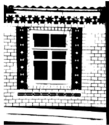
Рис. 12. Оздоблення вікон керамічною плиткою
