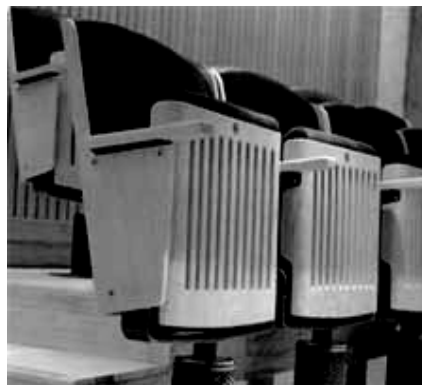
Рис. 5. Фрагмент ПР крісельного типу (працюють під тиском близько 10 Па)
