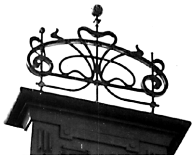
Рис. 9. Металеве завершення фронту будинку № 2 на вул. М. Вороного
