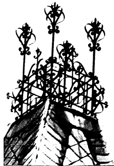
Рис. 4. Ковано-слюсарська решітка чотиригранної башти на вул. Дж. Дудасва, 8
