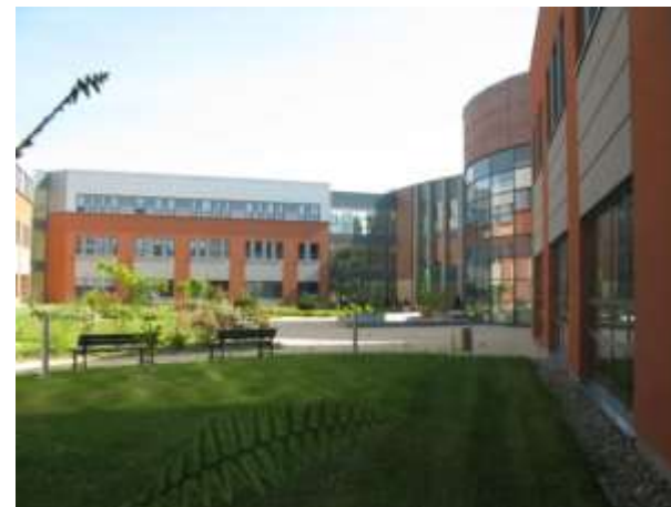
Widok z miejsc pracy w magazynie zamkniętym
