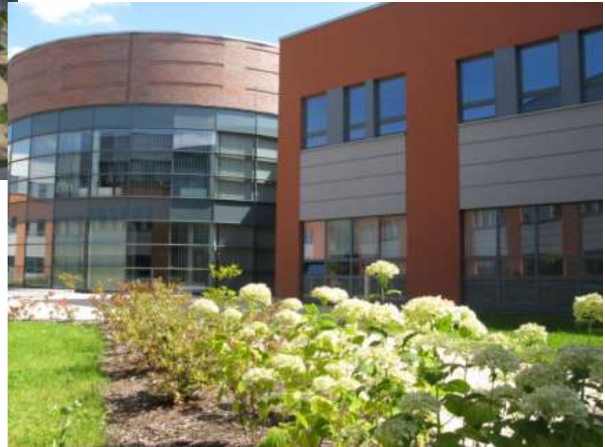
Nowe budynki Biblioteki WFAIS
