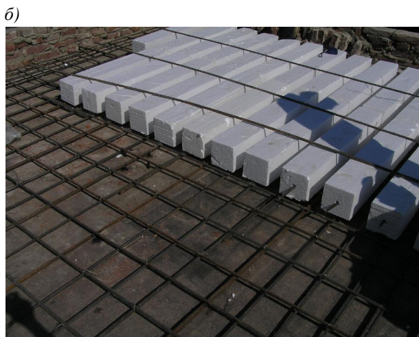
Рис. 8. Плоске монолітне залізобетонне перекриття розмірами в плані 7,6 \times 12,1 м з вставками: а – загальне конструктивне рішення перекриття (1 – муровані стіни; 2 – монолітний залізобетон; 3 – вставки з пінополістиролу); б – розкладання і фіксація вставок; в – бетонування перекриття
