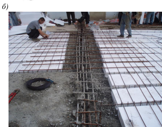
Рис. 10. Розташування вставок в плані і в перерізі перекриття (а), розкладання вставок і арматурних виробів (б) та бетонування перекриття (в): 1 – існуючі збірні пустотні плити перекриття; 2 – металеві балки; 3 – пінопластові вставки, В-1...В-3 – марки вставок за типорозміром
