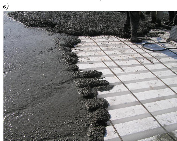
Рис. 8. Плоске монолітне залізобетонне перекриття розмірами в плані 7,6 \times 12,1 м з вставками: а – загальне конструктивне рішення перекриття (1 – муровані стіни; 2 – монолітний залізобетон; 3 – вставки з пінополістиролу); б – розкладання і фіксація вставок; в – бетонування перекриття
