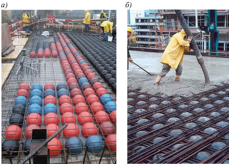
Рис. 13. Двонаправлене порожнисте перекриття системи COBIAХ: а – розташування модулів COBIAХ; б – бетонування перекриття з пластмасовими кулями
