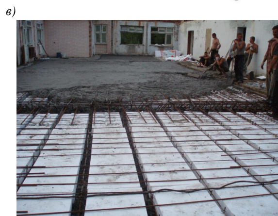
Рис. 10. Розташування вставок в плані і в перерізі перекриття (а), розкладання вставок і арматурних виробів (б) та бетонування перекриття (в): 1 – існуючі збірні пустотні плити перекриття; 2 – металеві балки; 3 – пінопластові вставки, В-1...В-3 – марки вставок за типорозміром
