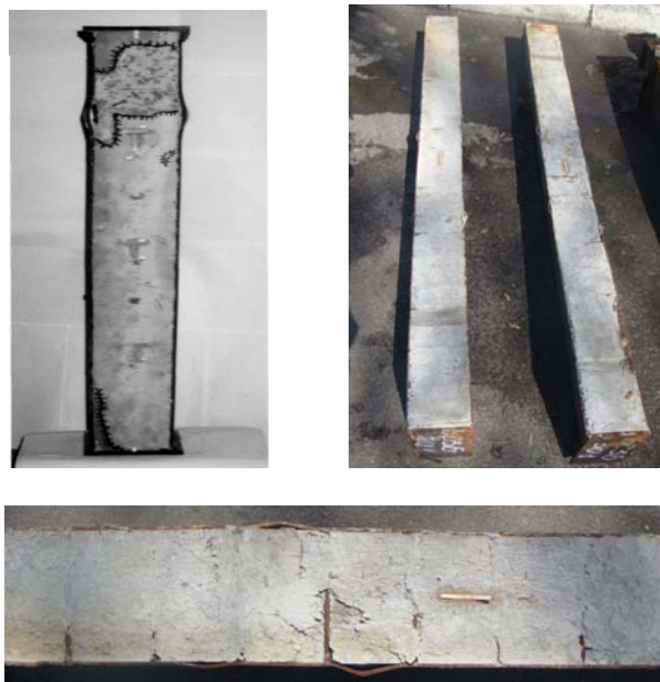
Характер руйнування сталезалізобетонних конструкцій із листовим армуванням
