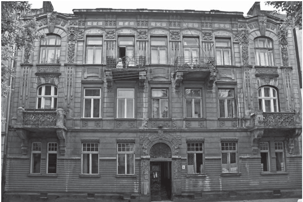
■ Будинок на вул. Академіка Богомольця, 6
