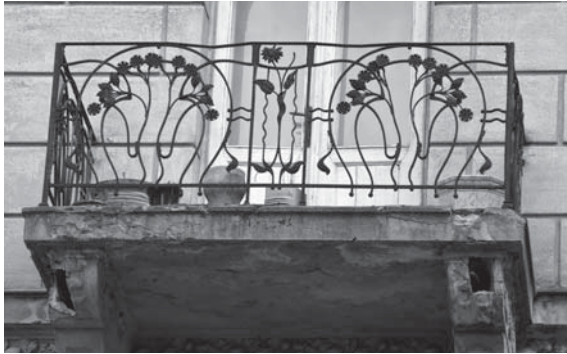
■ Балкон житлового будинку на вул. Левицького, 21
