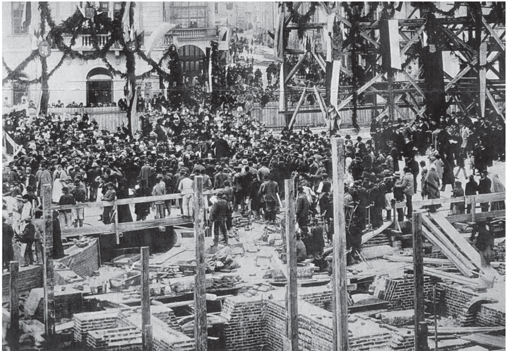
■ На будівництві Оперного театру
