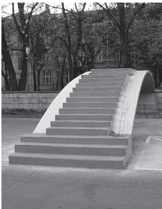
■ Залізобетонний місток біля головного корпусу Львівської політехніки
