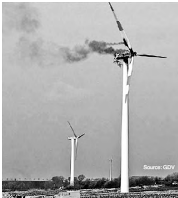
Рис. 1. Пожар ветротурбины в результате удара молнии г. Падерборн, Германия
