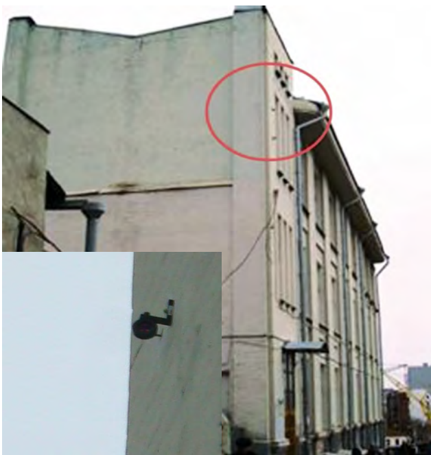
Рис. 7. Вид и расположение закрепленного отражателя
