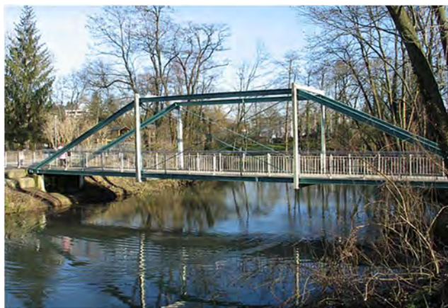
Рис. 2. Комбінований металевий мостовий перехід, Німеччина
