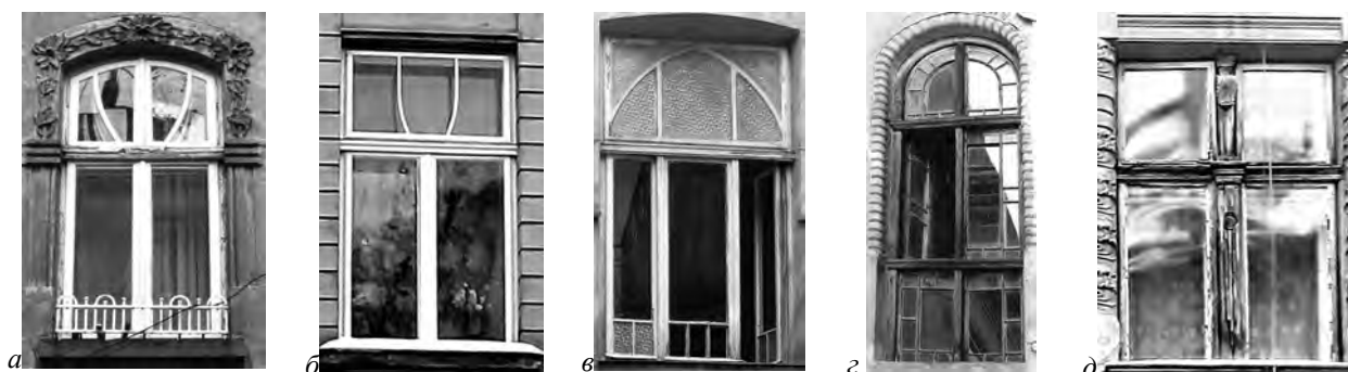
Рис. 11. Варіанти членування віконної столярки в орнаментальній сецесії: а – вул. Героїв УПА, 22; б – вул. Левицького, 16; в – вул. Бандери, 33; г – вул. Донцова, 7; д – вул. Севастопольська, 9
