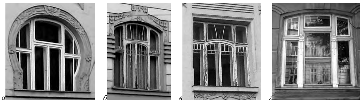
Рис. 12. Варіанти три- і чотиридільного членування віконної столярки в орнаментальній сецесії: а, б, в – пр. Шевченка, 4; г – вул. Шептицьких, 41 (зі стилізованим ордером)
