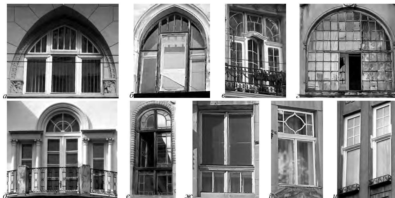
Рис. 14. Вирішення віконної столярки в раціональній сецесії: а – вул. Січових Стрільців, 12 (неоготика); б – вул. Дудаєва, 15 (неоготика); в – вул. Дорошенка, 19 (необароко); г – вул. Кременецька, 10 (необароко); д – вул. Франка, 150 (неокласицизм); е – вул. Хмельницького, 125; ж – вул. Галицька, 21; і – вул. Конопницької, 4; и – вул. Пекарська, 49
