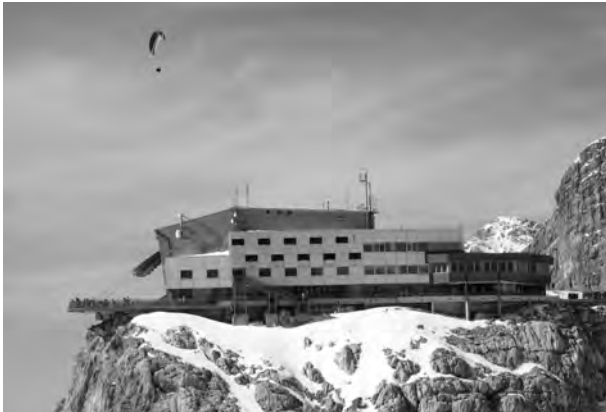
Рис. 9. Комплекс горішньої станції на г. Дахштайн у Штирії – Верхній Австрії
