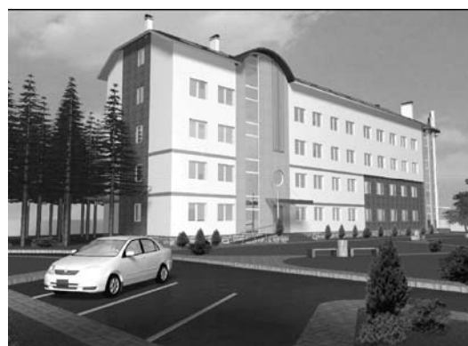
Рис. 15. Реконструкція нежитлових приміщень корпусу № 17 на вул. Кам'янецькій, 3 в м. Львові. ГПП: Ю.В. Петренко
