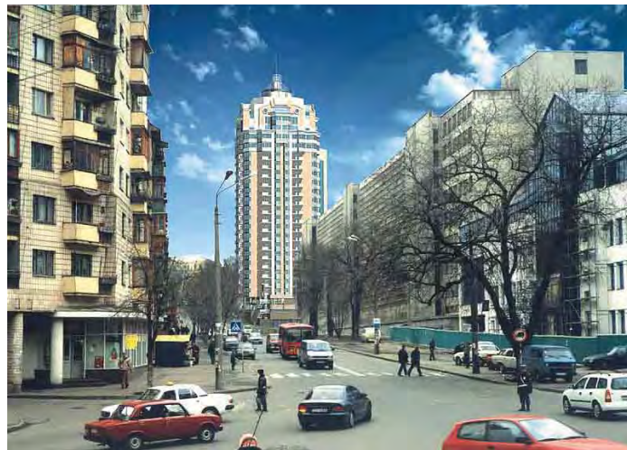
Рис. 5. Моносекційний будинок на вул. Кловський узвіз у Києві. С. Бабушкін, 2001–2003 рр.
