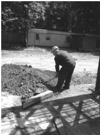
Рис. 4. Відгортання зворотної засипки від бокових граней фундаменту для проведення зондування бетону неруйнівними методами
