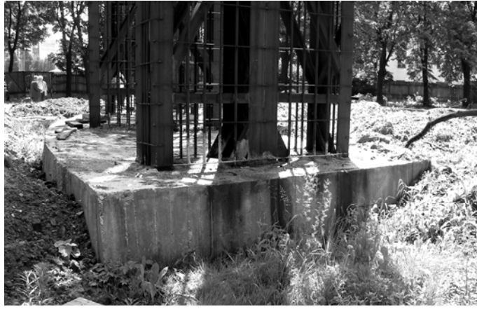
Рис. 1. Загальний вигляд фундаменту пам'ятника під час його обстеження
