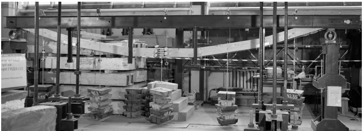
Рис. 3. Загальний вигляд установки для випробувань вантово-стрижневих конструкцій
