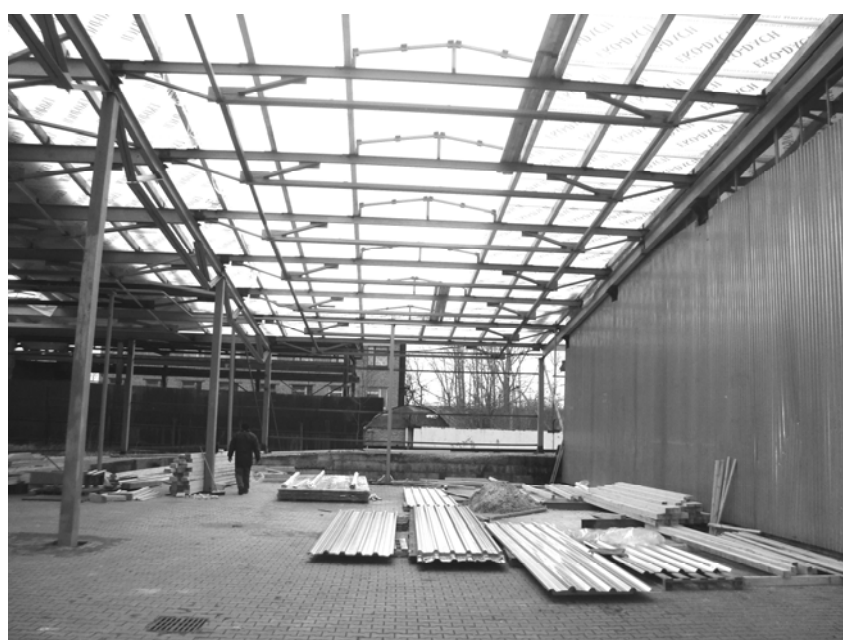
Рис. 11. Використання комбінованих металевих статично невизначених конструкцій як несучих елементів покриття навісу
