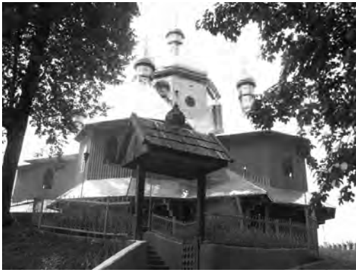
Рис. 12. Церква Собору Св. арх. Михаїла в с.Ясениці Замковій
