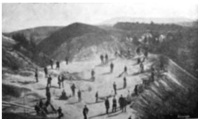
Рис. 13. Земляні роботи на Високому Замку, 1869
