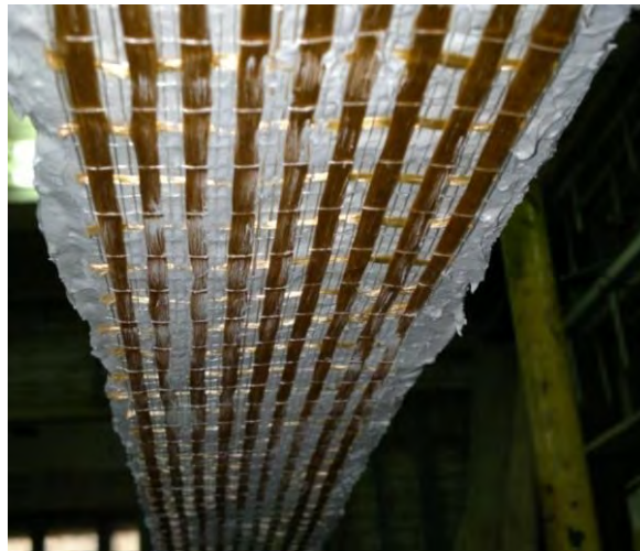
Рис. 5. Розташування сітки Ruredil X Mesh Gold у мінеральній матриці
