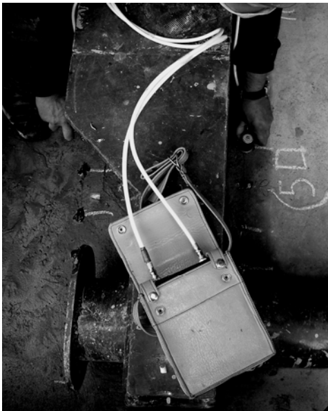
Рис. 7. Зондування бетону підготовки під балкою Б-2 рами компресора ультразвуковим методом у напрямку, перпендикулярному до осі балки. База прозвучування 380мм
