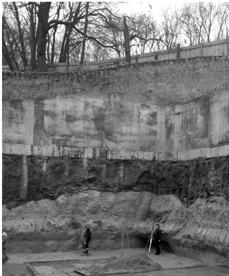
Рис. 1. Зовнішній вигляд підірної стіни, виготовленої по двох рядах буронабивних паль на вул. Бойківській у м. Львові
