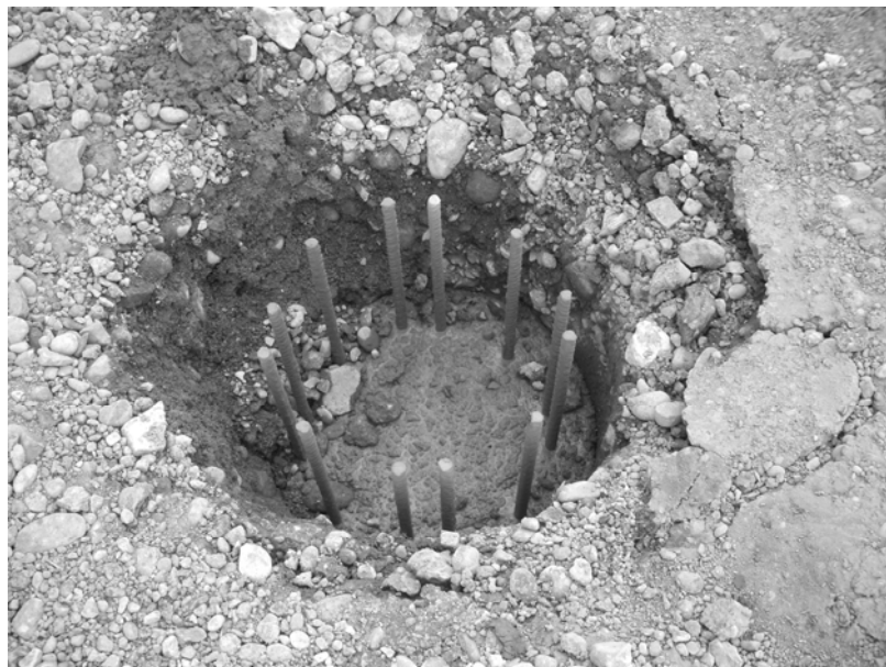
Рис. 3. Зовнішній вигляд свердловини, щойно заповненої бетоном
