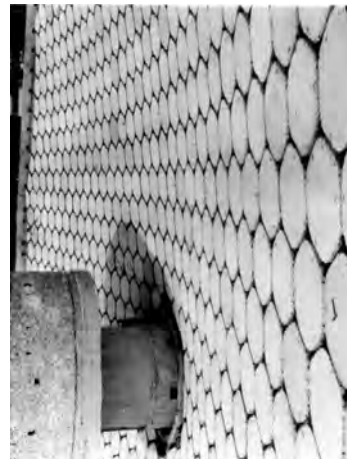
Рис. 2. Вигляд верхньої площини конструкції покриття (під час будівництва)
