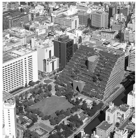
Рис. 6. Офісно-торговий центр Футуока-сіті в Японії [13]
