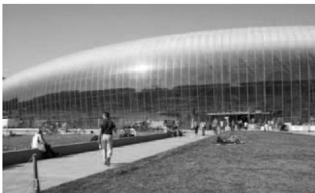
Рис. 7. Зовнішній вигляд вокзалу Страсбурга після реконструкції (Франція), 2007 р.
