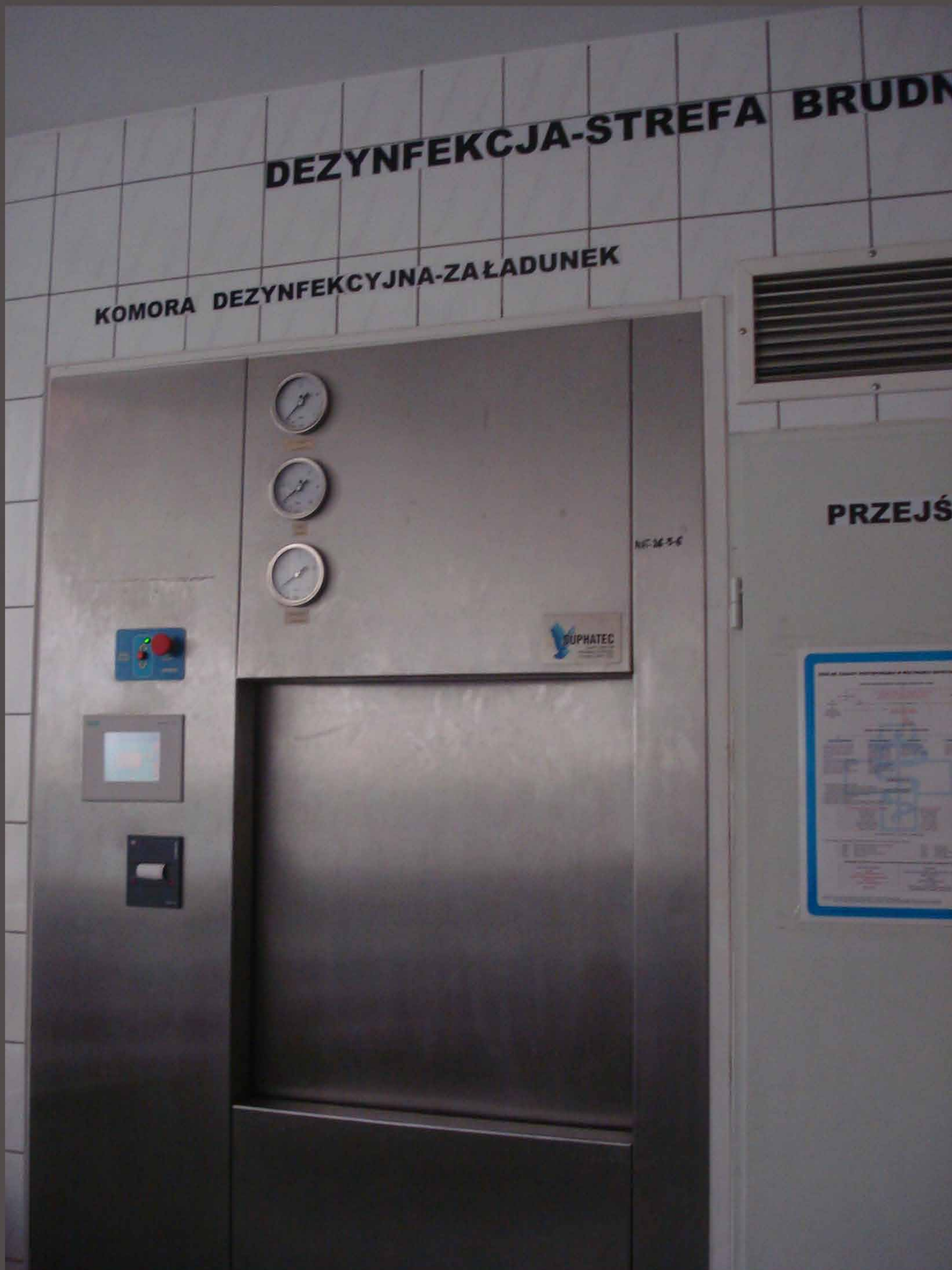
Камера для дезінфекції об'єктів окисем етилену
